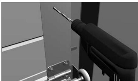
Просверлите отверстия Ø4,2 мм для крепления задвижки и отверстие Ø15 мм в угловой стойке для входления ригеля задвижки.
