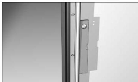
Закрепите угловые стойки к стене проема 2-я саморезами с шайбами, но не затягивайте их. Выставьте вертикальные направляющие по уровню и только после этого затяните саморезы.
