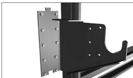
Установите выносные кронштейны для низкого вала к стене проема вплотную к угловой стойке (с внешней стороны) согласно монтажной карте. Закрепите к стене.
