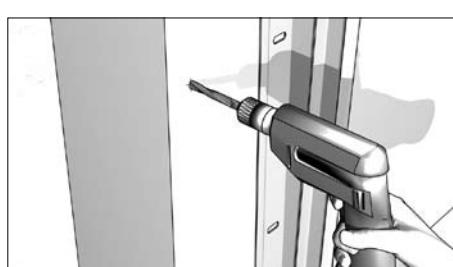
Просверлите отверстия  $\varnothing 12$  мм в стене проема. В отверстия забейте дюбели.
